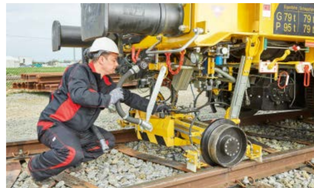
» Mitarbeiter der HANSA-FLEX Niederlassung Wels waren regelmäßig vor Ort, um den Prototyp des Universal Tamper zu verschlanchen und zu verrohren.
