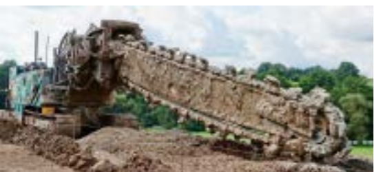
Foto/Photo: allcons Maschinenbau GmbH
