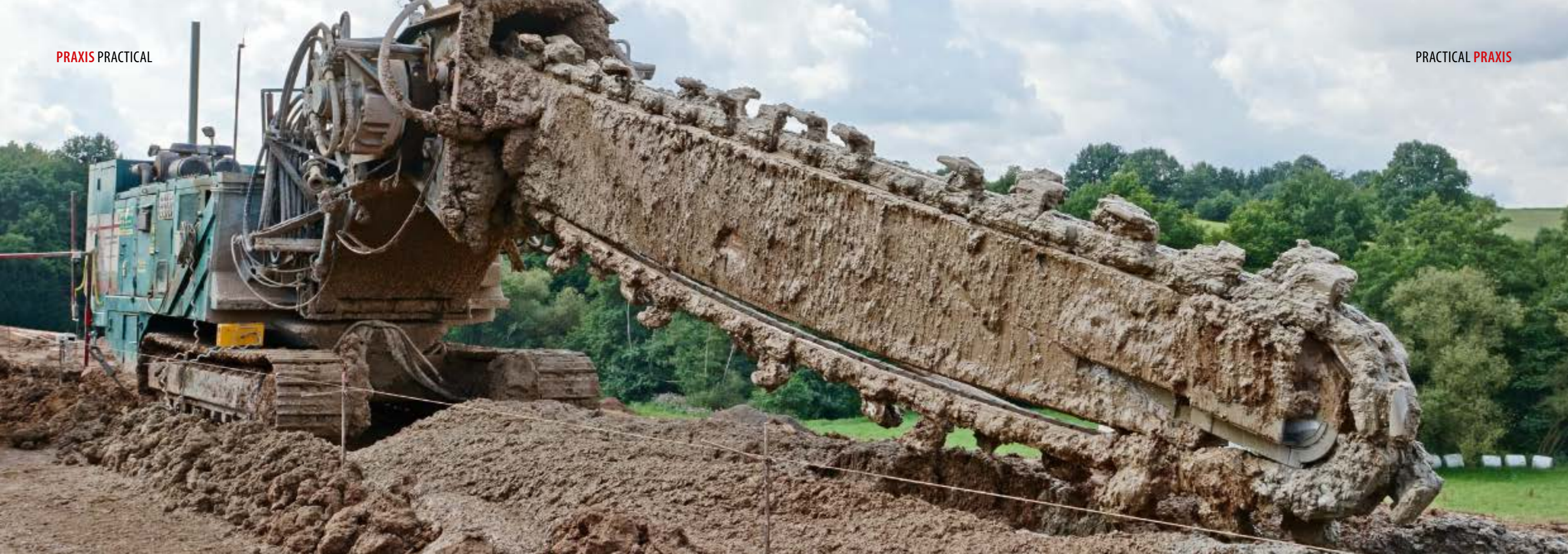
Foto/Photo: allcons Maschinenbau GmbH
